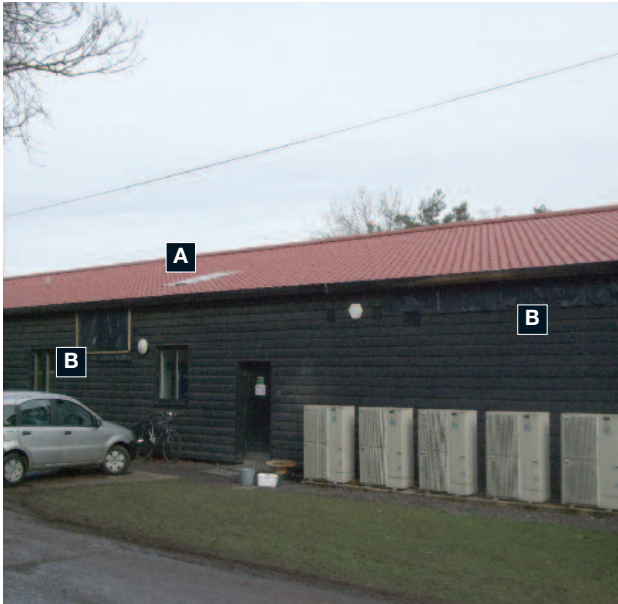
A : Ventilatieopening door brandweer in dak gezaagd. B : Ventilatieopeningen door brandweer in gevel gezaagd.
